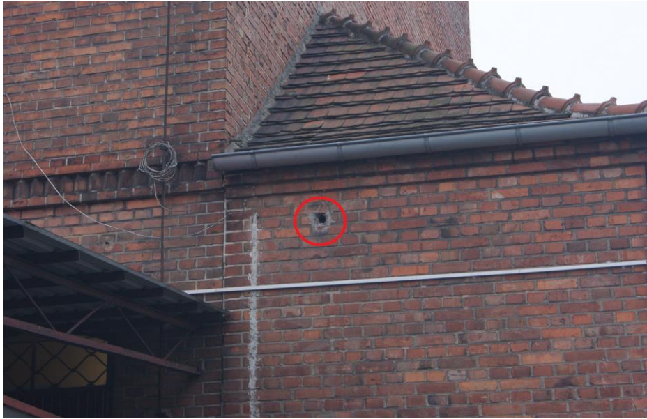
Fot. 4. Niezasklepiiony otwór (zaznaczony czerwonym kółkiem) na północno-zachodniej ścianie wtórnej przybudówki. Fot. J. Stępniewski.
